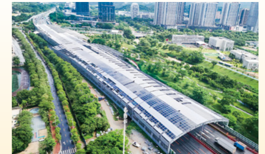
北二环高速全封闭声屏障工程项目
