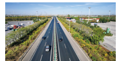
养护后的沙河特大桥桥面
